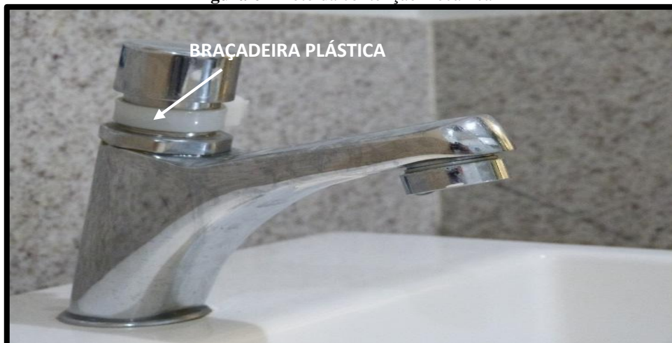
Figura 6 – Foto da contenção mecânica
